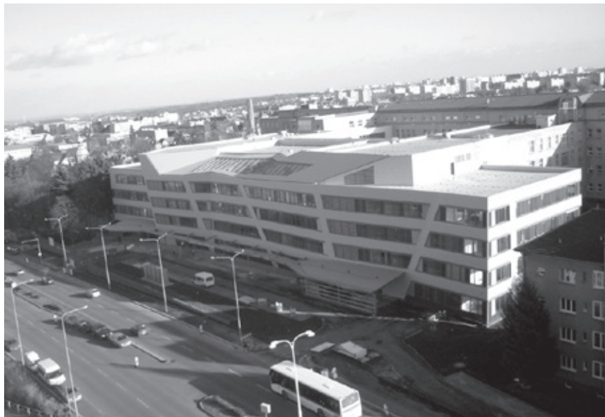
Obr. 1: Budova Centra akutní medicíny v ON Kladno
